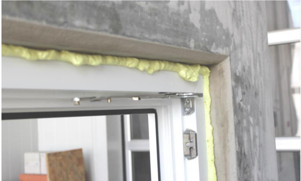
Prüfung die Schlagregen- und Luftdichtigkeit ohne zusätzliches Folienband, Verputzung und Verleistung sowie Zusatzabdichtung
