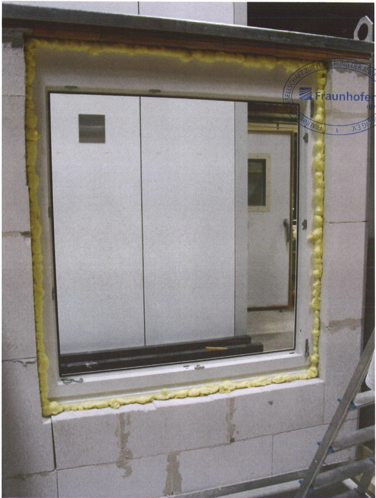
Bild 3: Einbau des Fensters mit Hilfe des PU-Dichtschaims „CLEAROPAG 167 Volumen-Aerosol-Klebstoff“.
